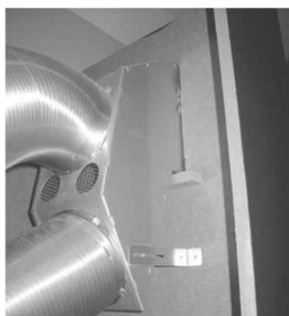
Griglia design 25x20 cm (2 raccordi diam. 150 mm)
